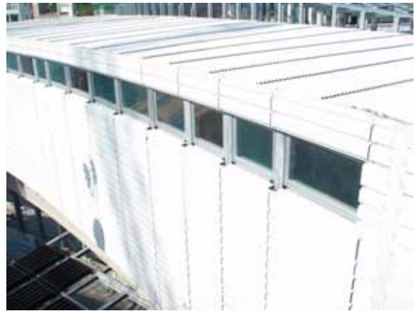
写真-1 排煙窓設置状況
