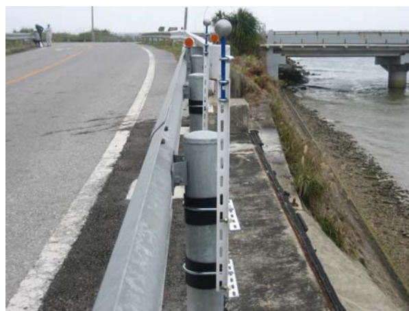
写真-1 試験体設置状況 (辺野喜橋)
