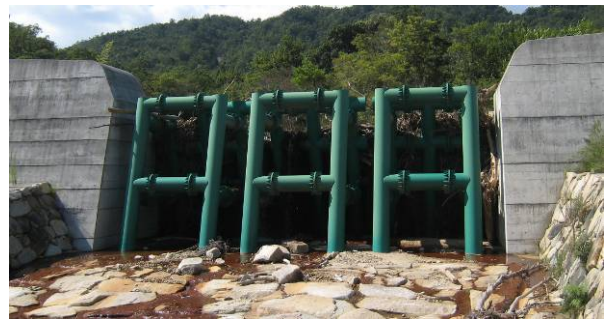
写真-1 鋼製透過型砂防堰堤
