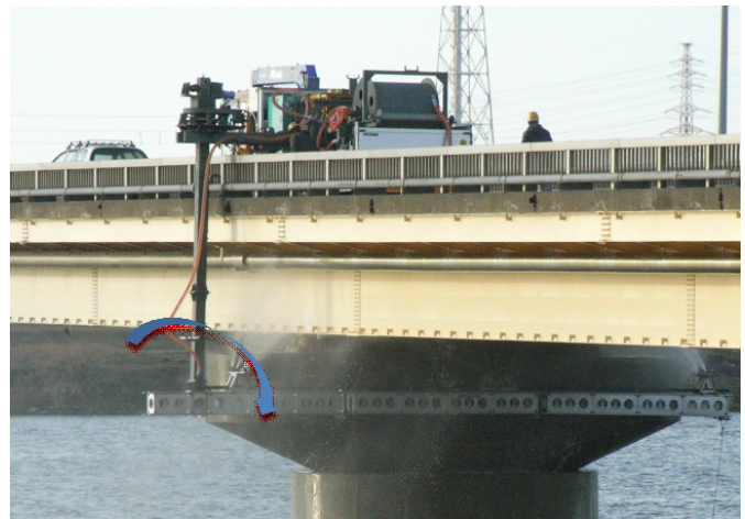
写真-1 橋梁洗浄の状況
