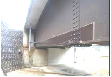
写真 3 山根橋部分補修塗装工事完成
