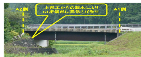
写真1 補修対象橋梁【山根橋前景】
