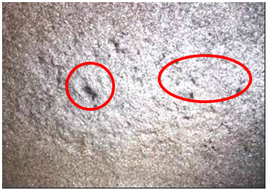
写真 2 孔食内の残存さび
