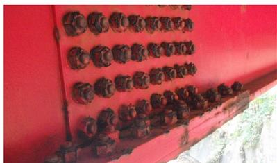
写真-1 ボルト部の発錆状況
