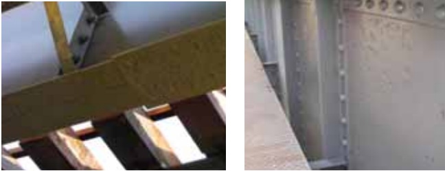
(a) 下フランジの凹凸部 (b) ウェブの凹凸部 図3 溶射工法箇所
