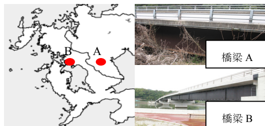
図 1 調査対象橋梁
