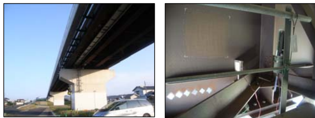
写真1 A橋の曝露試験状況
