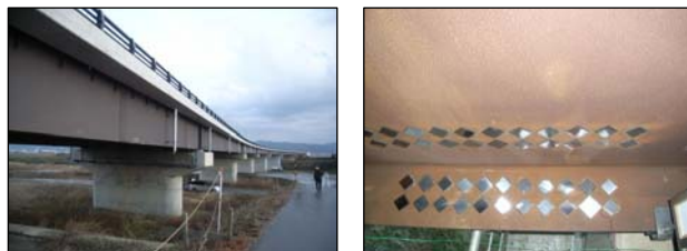
写真2 B橋の曝露試験状況
