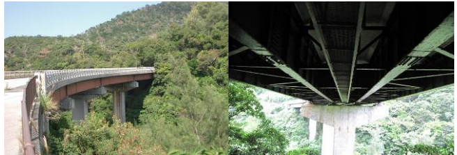
写真-1. A 橋および周辺状況
