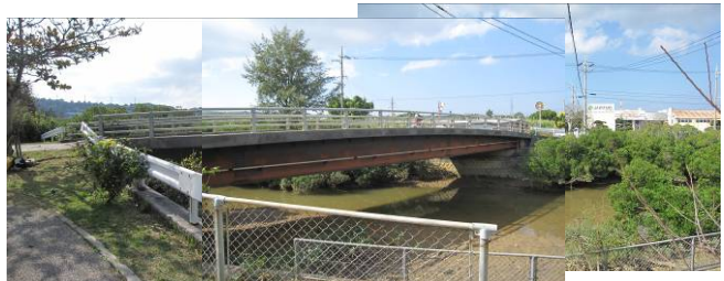
写真-2. B 橋および周辺状況
