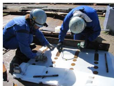
写真1 超音波厚さ計による腐食減耗量調査
