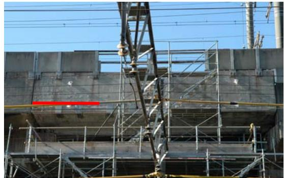
図 5 実橋梁で見つかった桁・側壁間の水平亀裂
