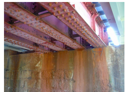
写真-1 架替対象橋りょう
