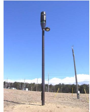
図1 柱状型トランスの外観
