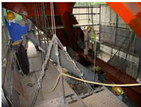
図-4 制震ブレースの架設状況
