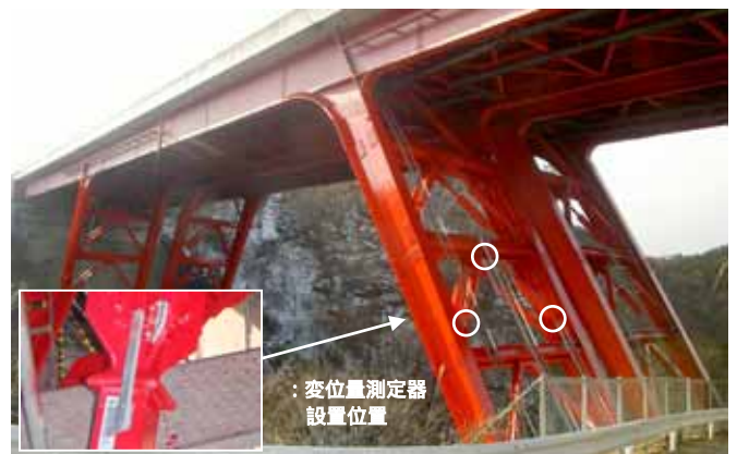
図-5 完成後全景および変位量測定器
