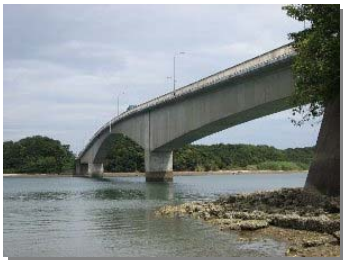
写真-1 (対象橋梁)
