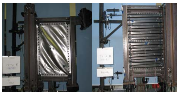
写真 1 せん断パネルの崩壊状況
