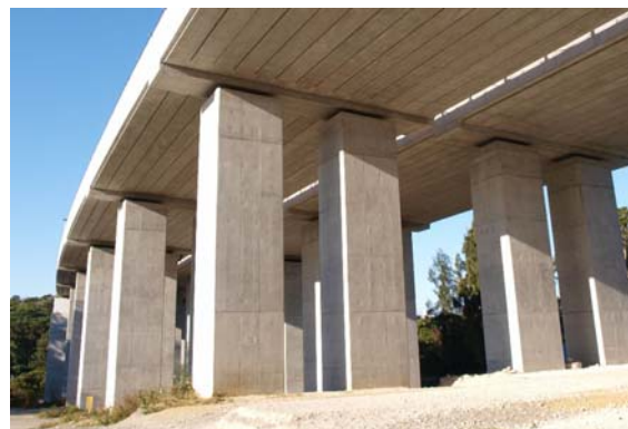
写真-1 新設した上部構造と2柱式橋脚
