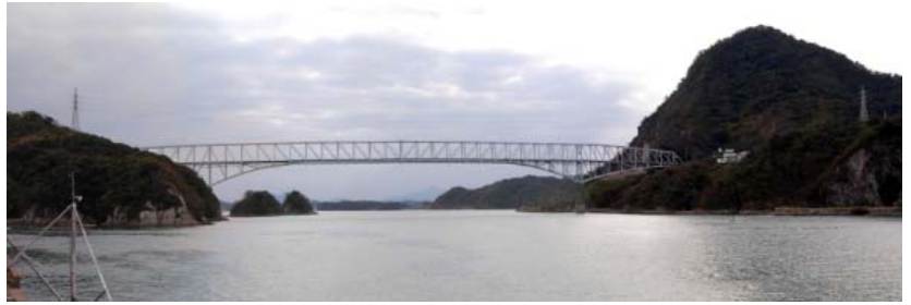
写真-1 現況写真
