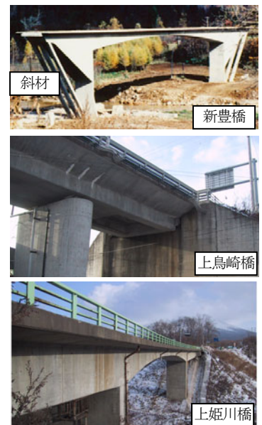
写真－1 突桁式構造
