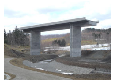
写真－2 炭山橋（橋体完成）
