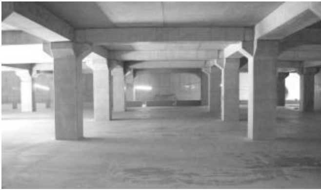
写真1 新広島市民球場 地下貯留池の内部 (鴻池組 HP より)
