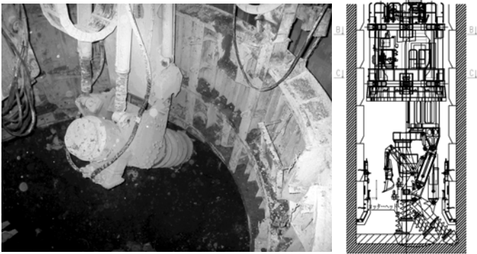
図 1 機械掘削状況
