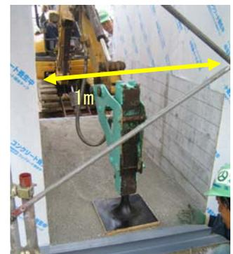
図-2 チゼルプレートによる締固め
