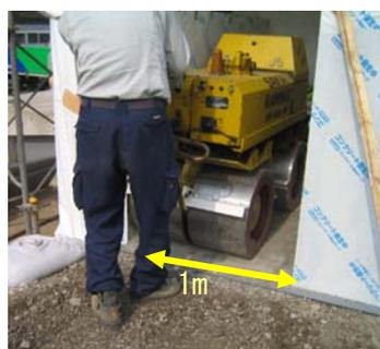
図-3 小型振動ローラーによる締固め
