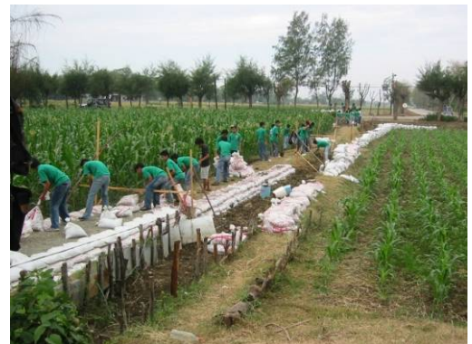
図 3 学生参加による歩道 (Phase II) 構築作業の様子
