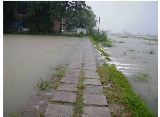
図 2 構築した歩道の雨季の様子 (この後水が引いても歩道は安定した状態であった.)
