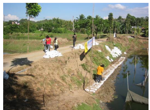
図 5 ため池堤防拡幅作業の様子 (水中から土のうを積み上げている.)
