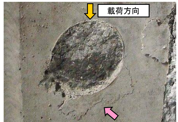
図 4 C30-A の破壊状況
