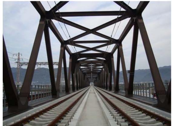
写真1. SRC床版合成トラスおよび軌道構造の状況
