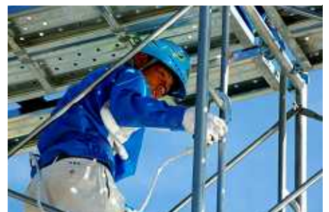
写真3 足場の組立て実習
