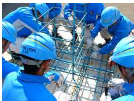
写真8 鉄筋の組立て実習
