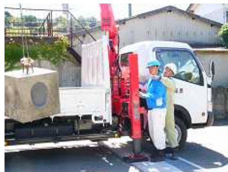
写真4 小型移動式クレーン実習
