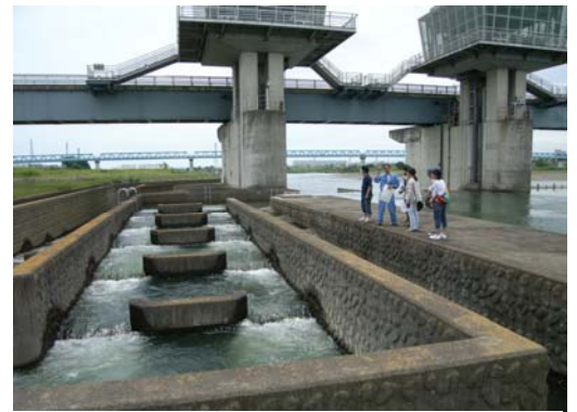
写真1 相模大堰全景と魚道施設
