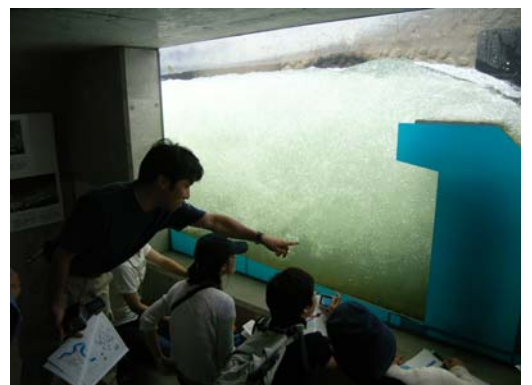
写真2 魚道側面に設けられた観察窓
