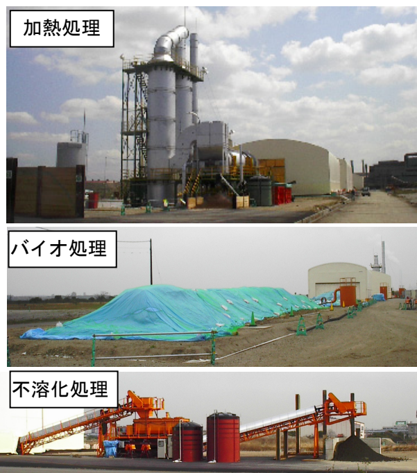
写真-1 各処理の施工状況
