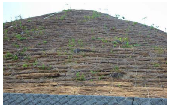
写真-1 ケイ酸質含有植物を用いた押伏せ工
