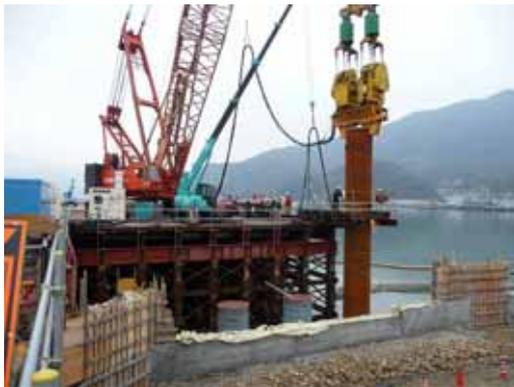
図3 バイプロハンマによる鋼管杭打設状況
