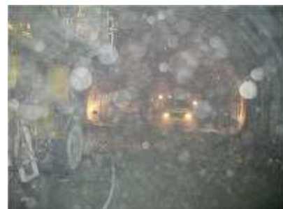
写真-2 トンネル坑内の撮影
