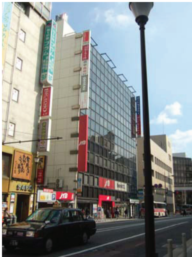
写真1 調査対象業務ビル
