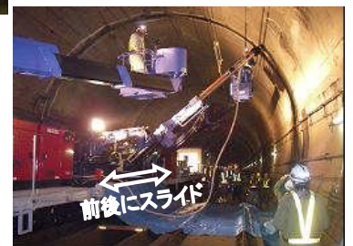
写真－3 ロックボルトの施工
