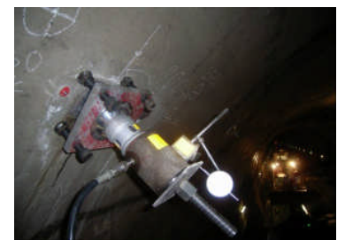
写真－4 引抜き試験
