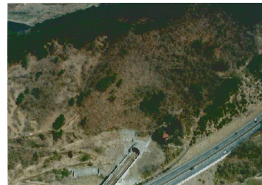
写真-1 トンネル坑口の状況
