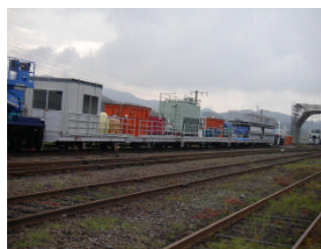
写真－2 保守基地（延伸後）
