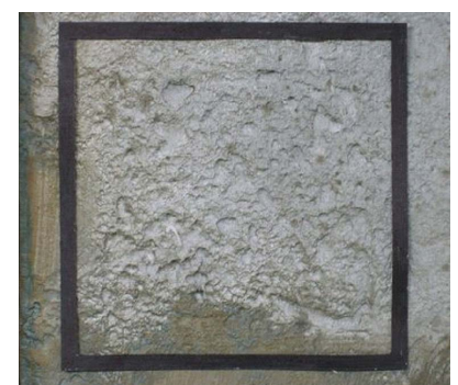
耐海水性ステンレス被覆 損傷部(50mm×50mm)
