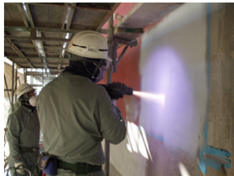
写真-1 亜鉛・アルミ擬合金の溶射状況
