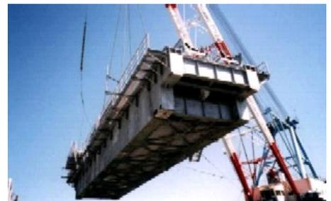
写真-3 新設上部工架設状況
