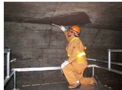
写真2 天井面補修箇所の打音検査状況
