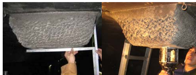
写真 1 天井面厚吹き試験箇所（一層厚さ 200mm）
