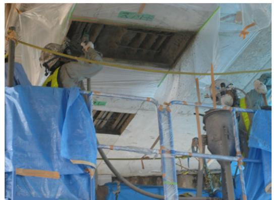
写真2 吹付け試験状況
