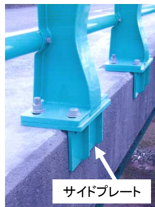
写真-2 本工法支柱基部
