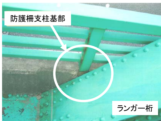
写真-1 下路式ランガー桁の既設地覆
