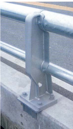
写真-7 防護柵支柱
