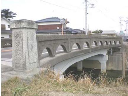
写真-5 既設 RC 高欄
