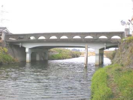
写真-4 橋梁全体
