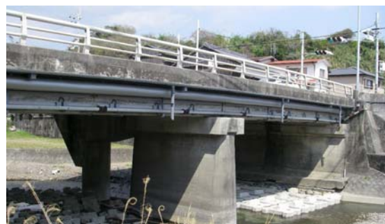
写真-1 穴内橋全景
