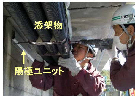
写真－4 添架物を避けての陽極配置作業
