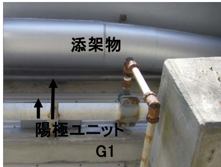
写真－3 G1 桁側面に設置された添架物
