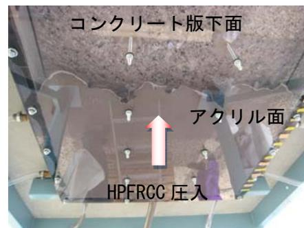
写真-1 HPFRCC 圧入状況
