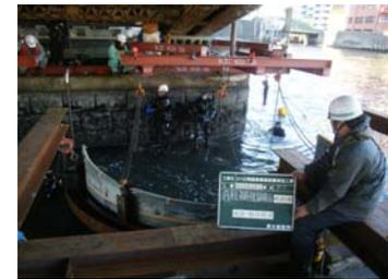
写真-4 台船から吊装置へ
