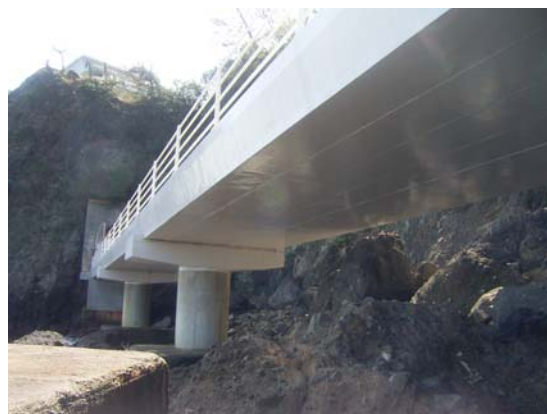
写真 2 補修後の PC 桁
