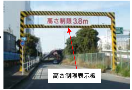
写-3 改良後の門柱
