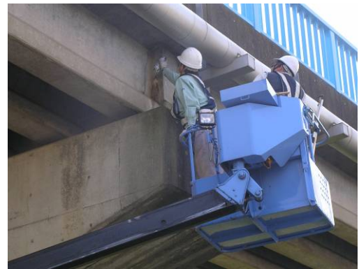
図- 1 定期点検状況
