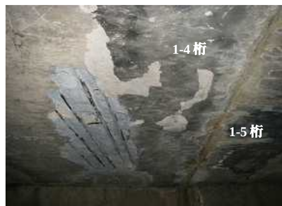
写真-1 RC 桁下面状況 (1-4 桁)
