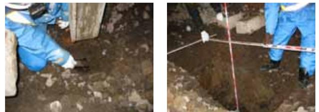
写真-2 掘削による空洞確認
