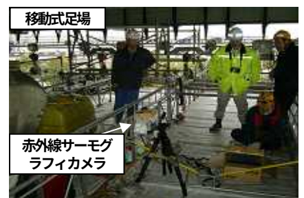
図2. 鋼床版下面からのUリブ観測風景
