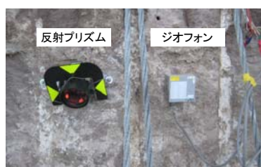
図6 岩塊表面の機器設置状況
